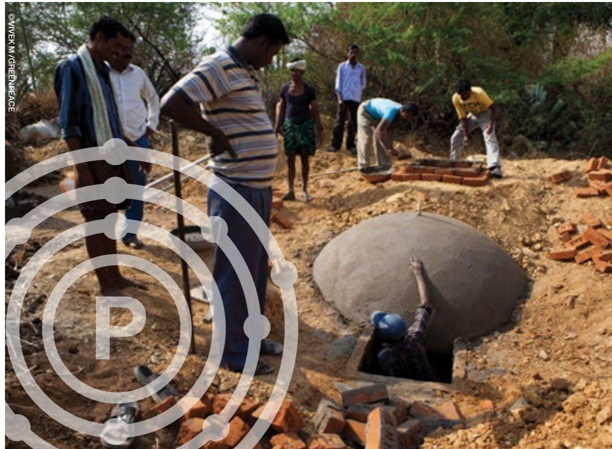
Új biogáztárolót építő munkások (Kammavariipalli, Bagepalli taluk, India)
